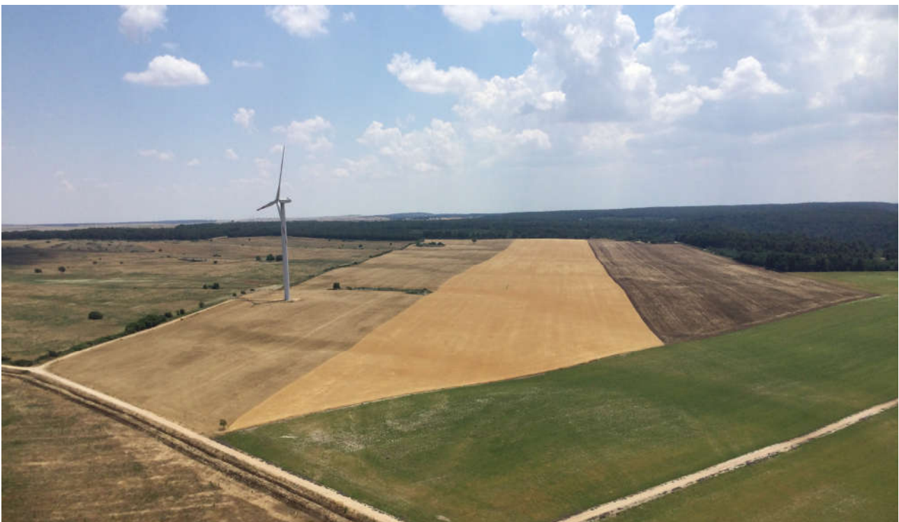
Figura 15 - Vista parco eolico
