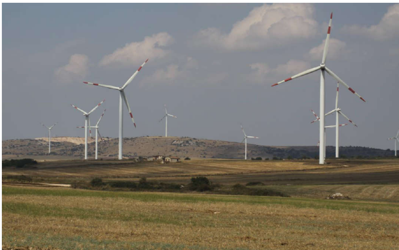
Figura 10 - Vista parco eolico
